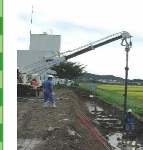
鋼管杭 φ139.8 先端φ250 L=6.0m×152本 " " L=8.0m×68本
