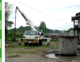
鋼管杭 φ114.3 先端φ200 L=5.0m×32本
