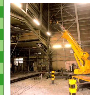
鋼管杭 φ165.2 先端φ250 L=12.0m 12本
