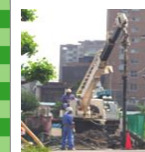
鋼管杭 φ139.8 先端φ250 L=8.0m 4本
