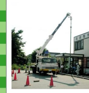
鋼管杭 φ139.8 先端φ250 L=12.0m 4本
