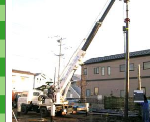
鋼管杭 φ190.7 先端φ375 L=7.0m×16本
